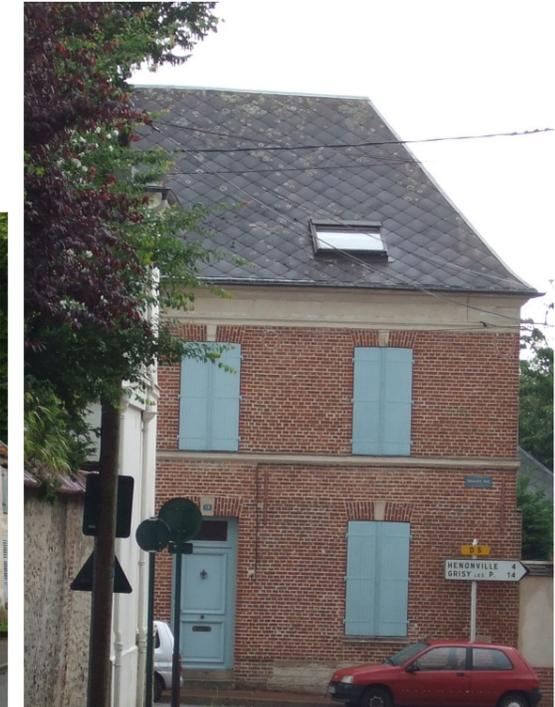
*Façade en pierres à silex, enduits ton pierre et bois et construction en briques rouges*
