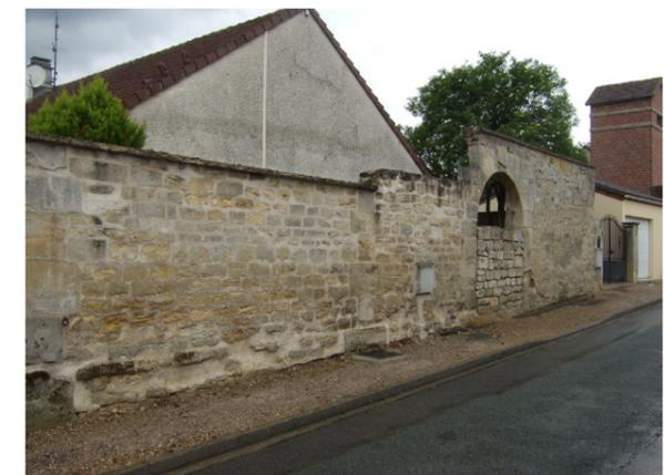
*Mur ancien en pierres à silex et pierre de taille et mur en pierre calcaire (moellons)*
